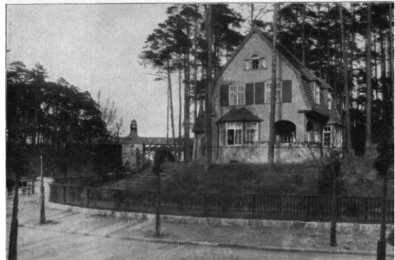
Haus Ihmsen von Paul Poser. Im Hintergrund erkennt man das Transformatorenhaus von Heinrich Straumer mit der heute zerstörten Brücke.
