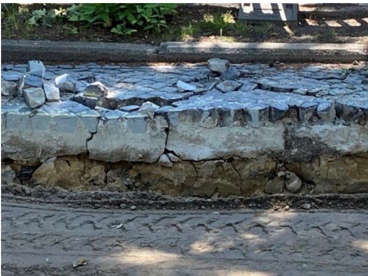
Abb.: Betondecke unter dem Pflaster. Mittlerweile ist das Pflaster bis über die Höhe Markgrafenstraße vollständig entfernt (Quelle: Bürgerverein)
